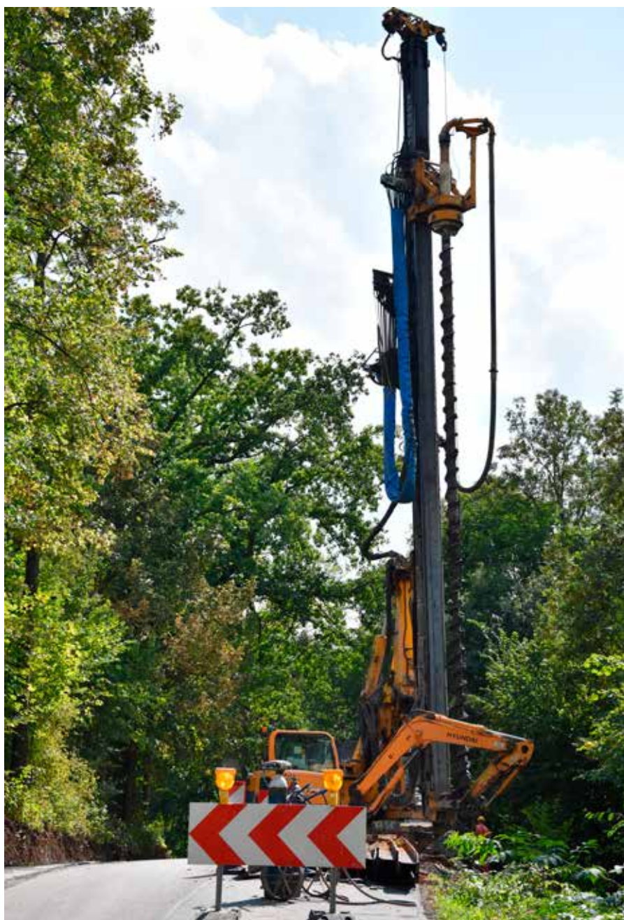
Wykonywanie palisady
