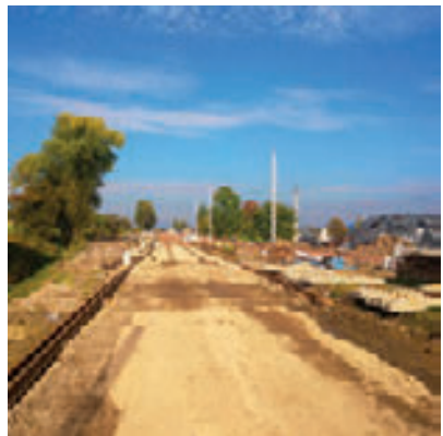
Stacja Goleiszów w trakcie remontu
