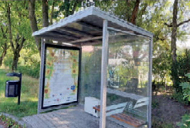
Na terenie gminy ustawiono 10 nowoczesnych przystanków autobusowych
