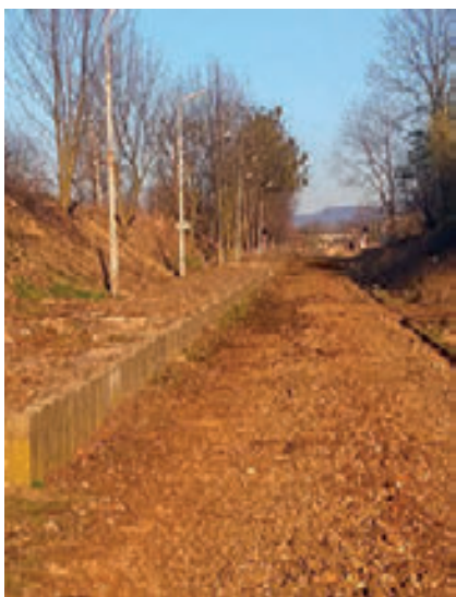
Stacja Bażanowice w trakcie rewitalizacji
