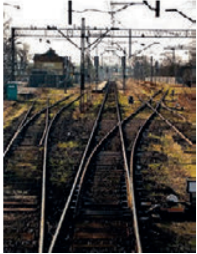
Stacja Goleiszów przed rewitalizacją
