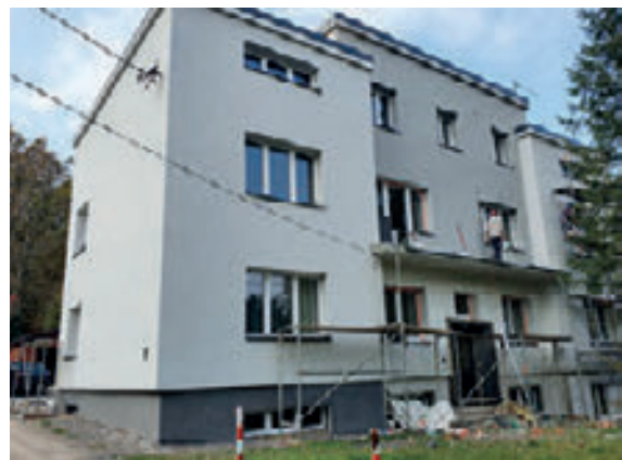
Termomodernizacja Domu nauczyciela w Cisownicy
