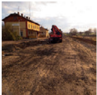
Stacja Goleiszów w trakcie remontu, w tle budynek dworcowy z 1888 r.
