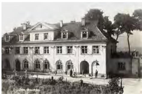
Dom dziecka po przebudowie.
