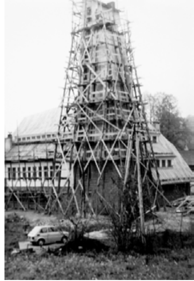
← ↑ W trakcie budowy.
