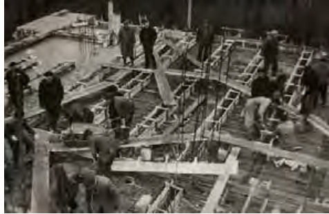
Betonowanie stropu.
