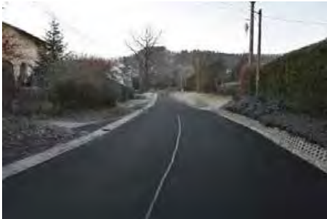
Wyremontowano ul. Górską w Golezowie.
