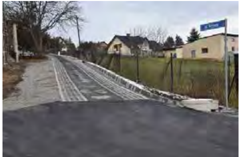
Wyremontowano ul. Stromą w Puńcowie.
