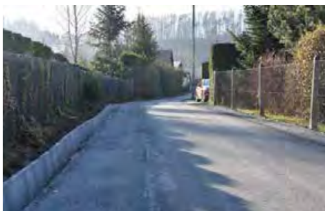
Ul. Pod Goruszką w Goleiszowie.
