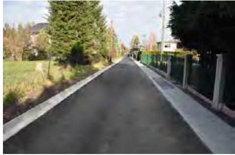
Wyremontowano ul. J. Ożany w Cisownicy.
