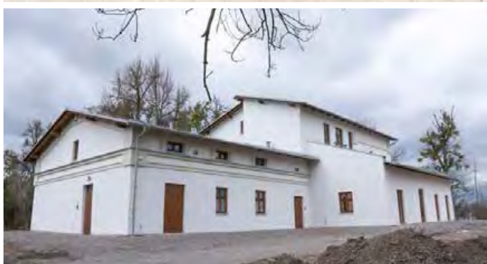
Ośrodek przed i po remoncie | fot. z archiwum PSONI.
