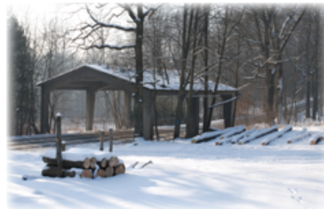
Zadaszenie nad drogą Přístřešek nad cestou
