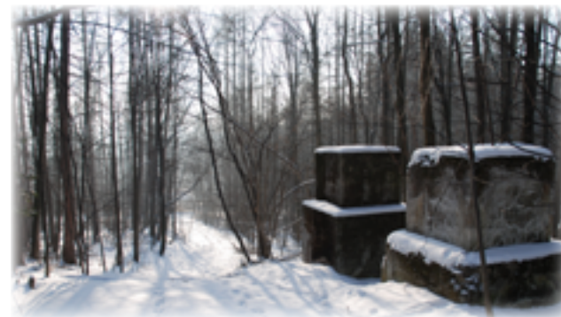
Szlak zimová pora - pozostatky betonových podpór kolejki Trasa v zimě - pozůstatky podpěr lanovky
