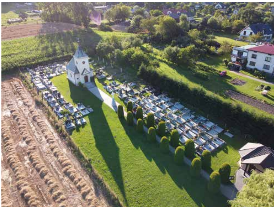
Kościół w Godziszowie. Fot. M. Fielek
