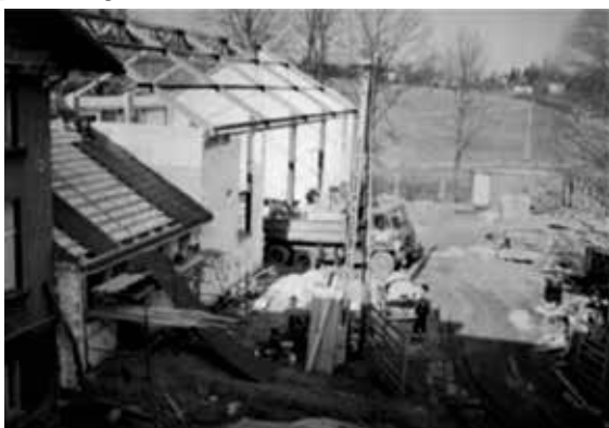
1999, Budowa sali gimnastycznej
