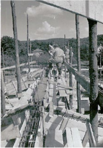
Budowa kaplicy w Dzięgielowie
