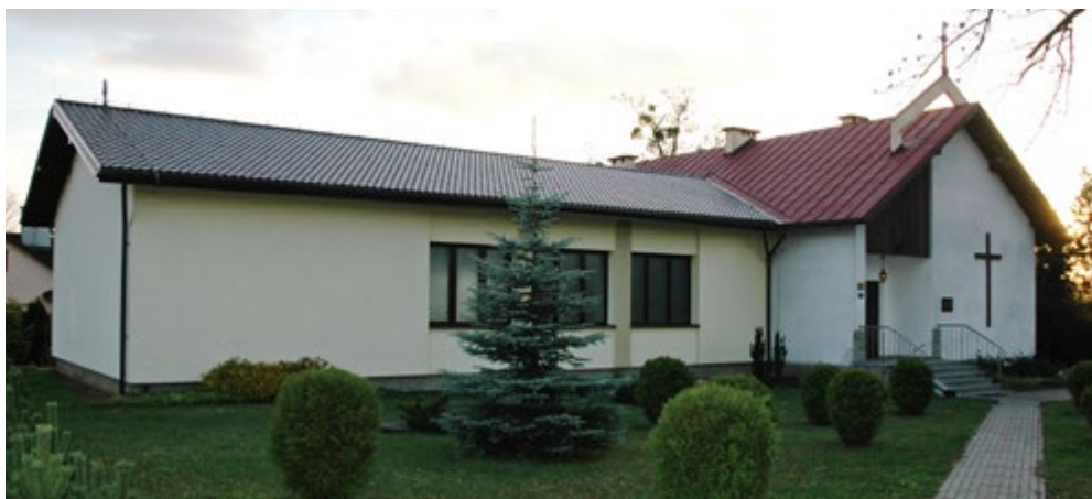
Dziegiełowska kaplica. W 2015 r. nad częścią świątyni wykonano nowe pokrycie dachowe a wewnątrz drewniany sufit
