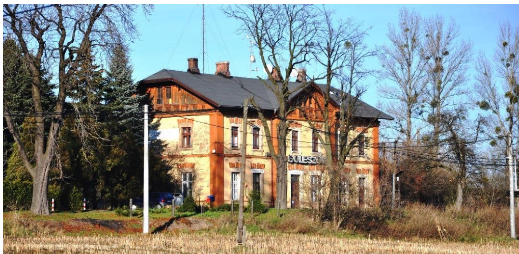
Fot. 10. Stacja PKP Goleiszów Główny, fot. B. Buława, 10.2015
