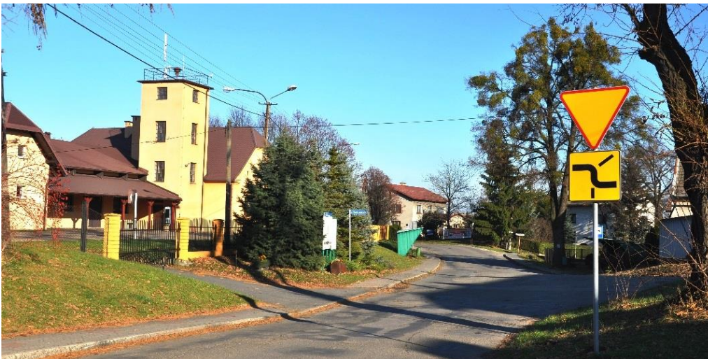
Fot. 1. Remiza OSP w Kisielowie, fot. B. Buława, 10.2015
