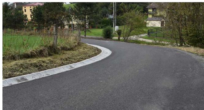
ul. Zamkowa w Bażanowicach po remoncie
