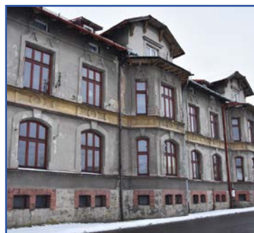
Goleszów, ul. Grabowa 11 – budynek przeznaczony do modernizacji
