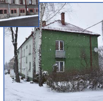
Cisownica, ul. Cisowa – budynek przeznaczony do modernizacji
