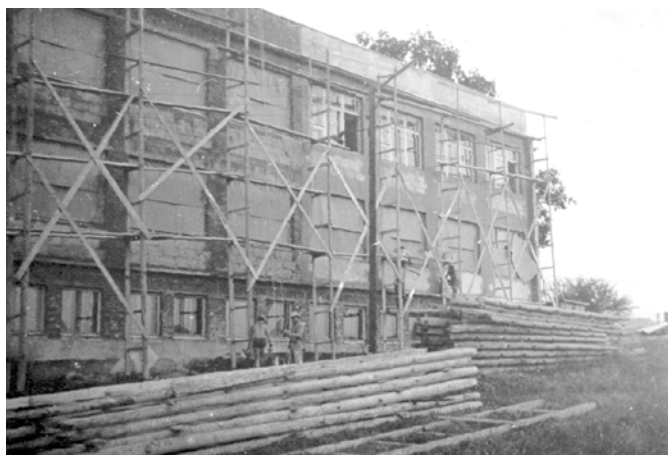
Kładzenie tynków
