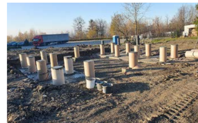
Fundamenty pod tężnię | fot. M. Śmierciak
