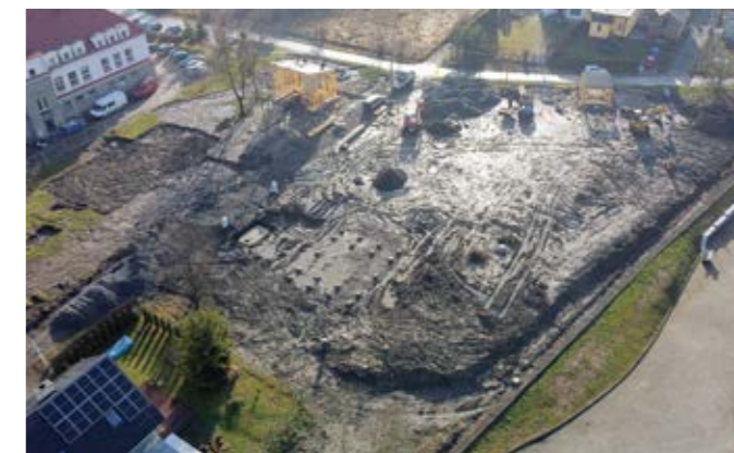
Widok na powstający kompleks z lotu ptaka | fot. M. Fielek
