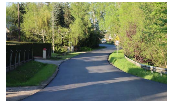
Wyremontowany odcinek ul. Cieszyńskiej w Puńcowie
