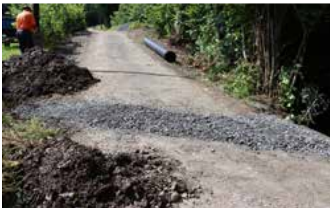
Ulica Potok w remoncie
