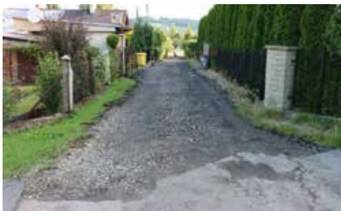
Ulica Kasztanowa w remoncie
