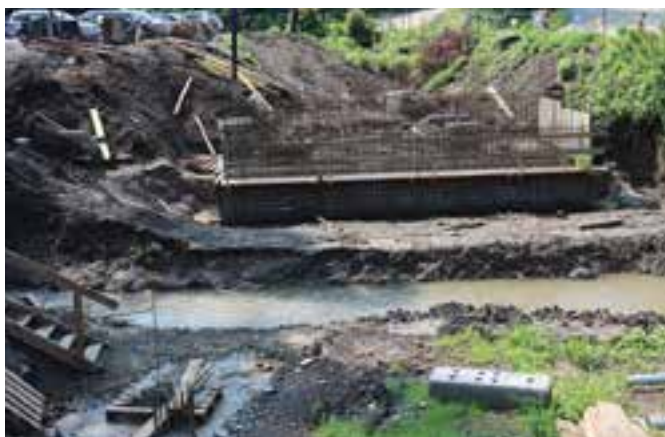
Budowa mostu nad Puńcówką
