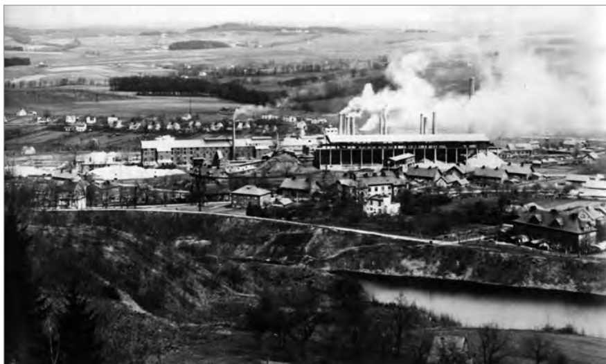
Widok na cementownię, widoczna podpora z siatką oraz dwa wagoniki w lewo od podpory (na białym tle). Zdjęcie z roku 1959. Foto Jan Czudek.
