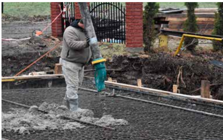
Betonowanie płyty głównej
